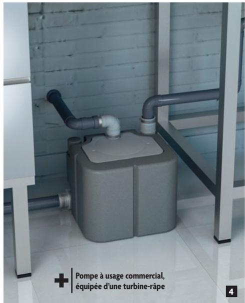
+ Pompe à usage commercial, équipée d'une turbine-râpe
